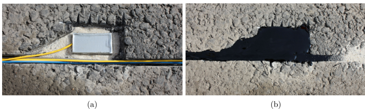
Obrázek 4.8: Vyfrézovaná vozovka s umístěným FBG snímačem zapouzdřeným do polymeru PDMS (a); zalití vyfrézovaných děr s FBG snímačem tekutým asfaltem (b).
